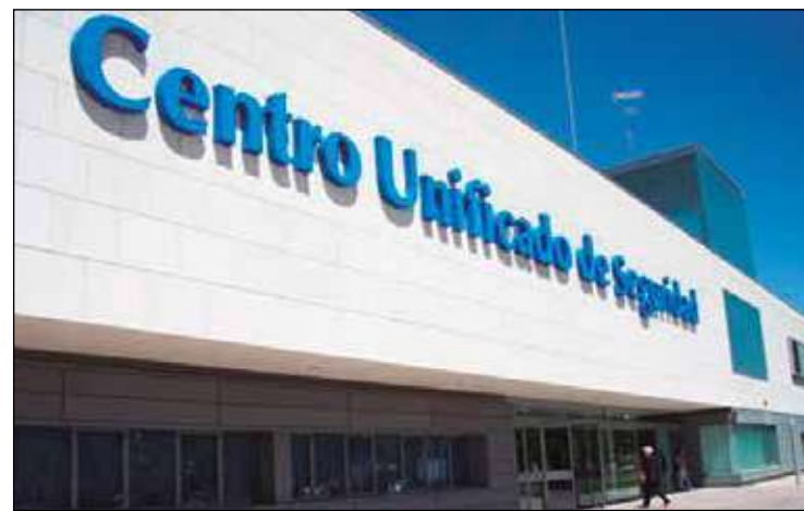
Fachada del Centro Unificado de Seguridad (CUS)
