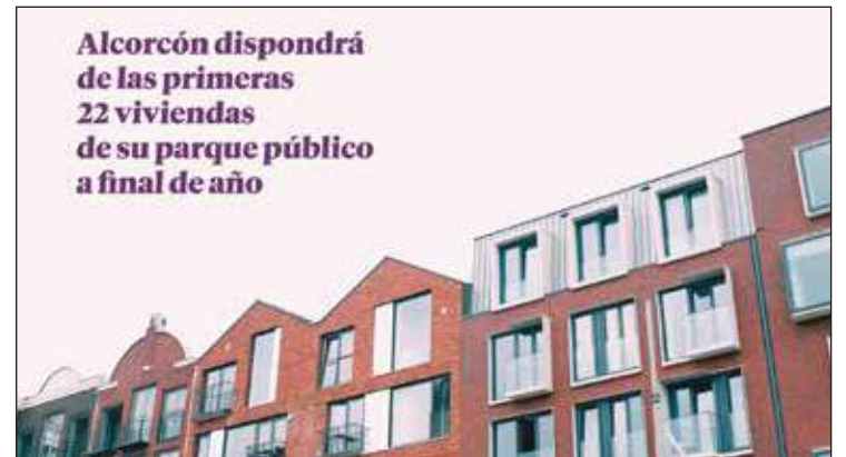
Ya han finalizado los correspondientes trabajos de adecuamiento
