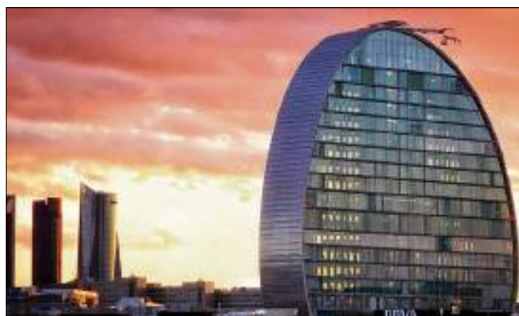
El sistema de control Domótico del edificio 'La Vela', ha sido uno de los premiados.
