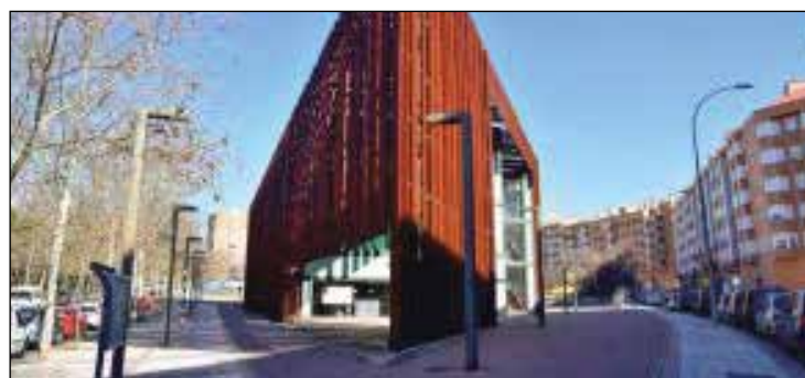
La construcción de los centros es una reivindicación histórica del municipio
