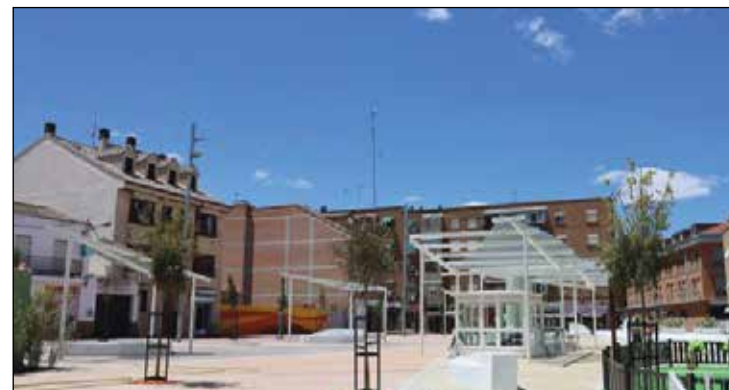
La Plaza del Tesillo tras las obras de remodelación
