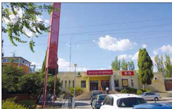
Se rehabilitarán las zonas de andenes y una zona adaptada a personas con movilidad reducida
