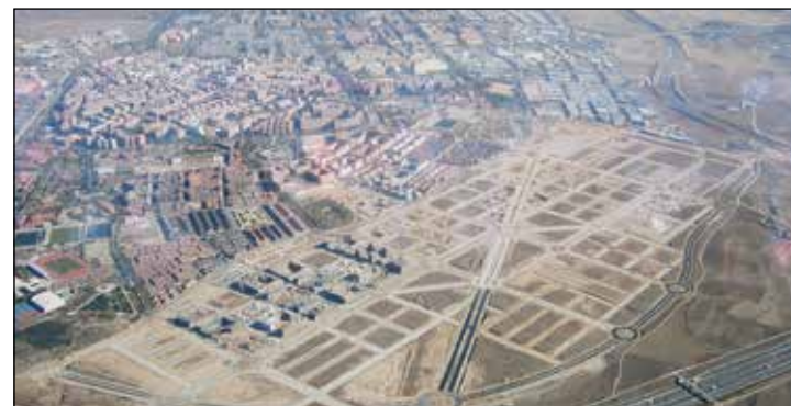
Vista aérea del Ensanche Sur de Alcorcón, lugar donde se construirá el colegio
