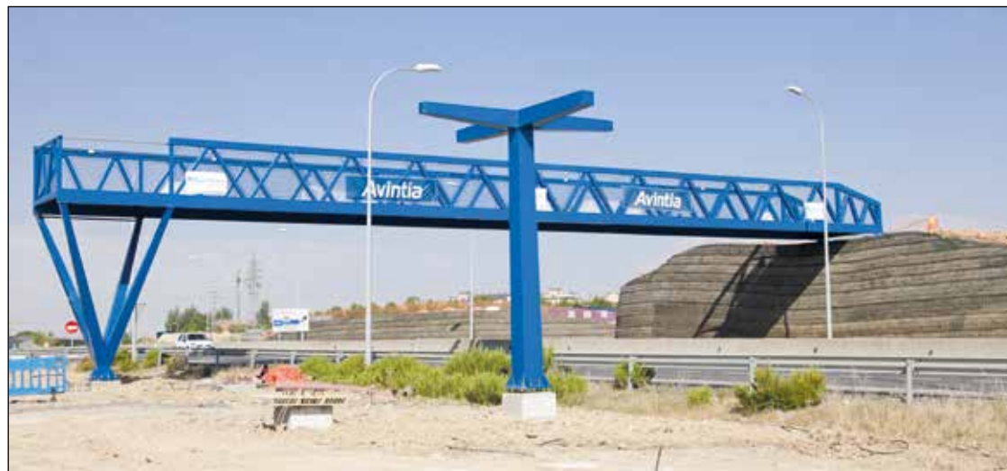
La gran pasarela peatonal, que tras su instalación, hará más seguro acceder a la zona comercial sin tener que cruzar la M-406
