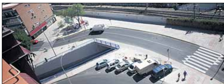
Aspecto del puente de la calle Móstoles tras la finalización de las obras.
