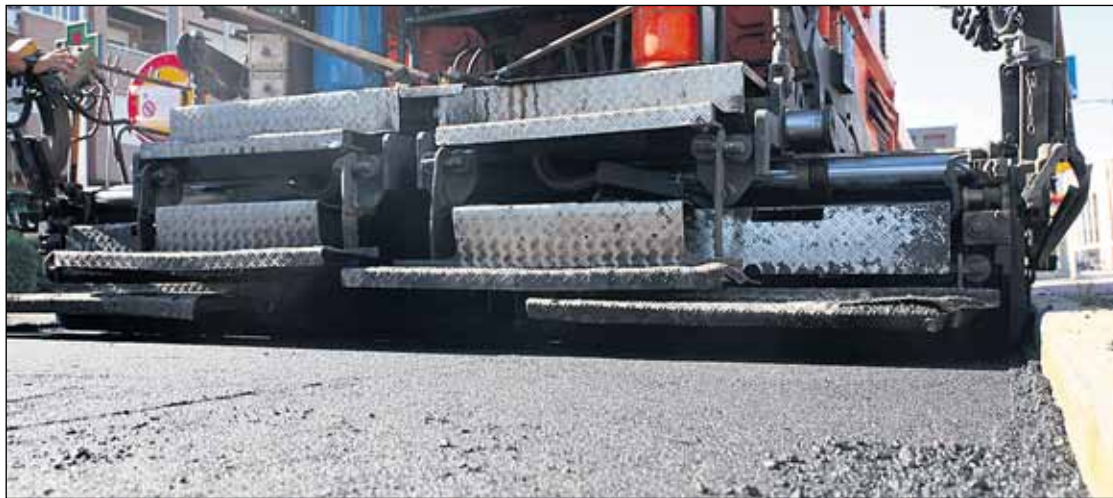
El Plan de Asfaltado de este verano cuenta con un presupuesto de algo más de 1,2 millones de euros
