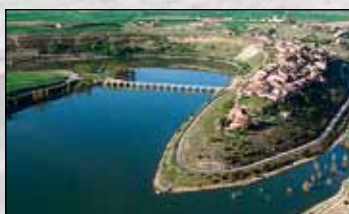
Vista aérea de la Villa de Maderuelo.
