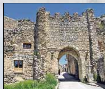
Puerta o Arco de la Villa.
