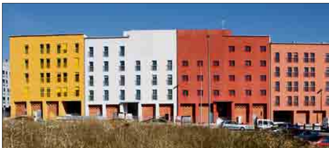
La Comunidad de Madrid, ha destinado 10,8 millones de euros para la construcción de 140 viviendas sociales en Alcorcón.
