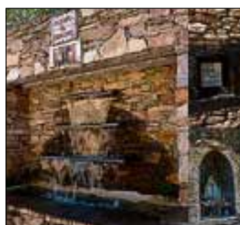
Fuente El Corcho, de reciente construcción
