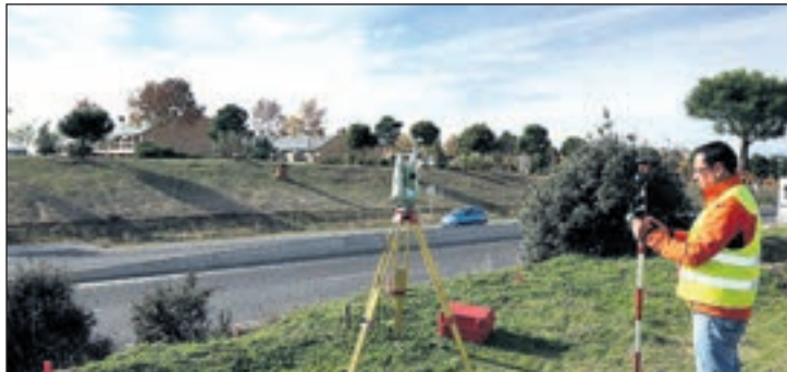
La nueva infraestructura tendrá un periodo de ejecución de cinco meses.
