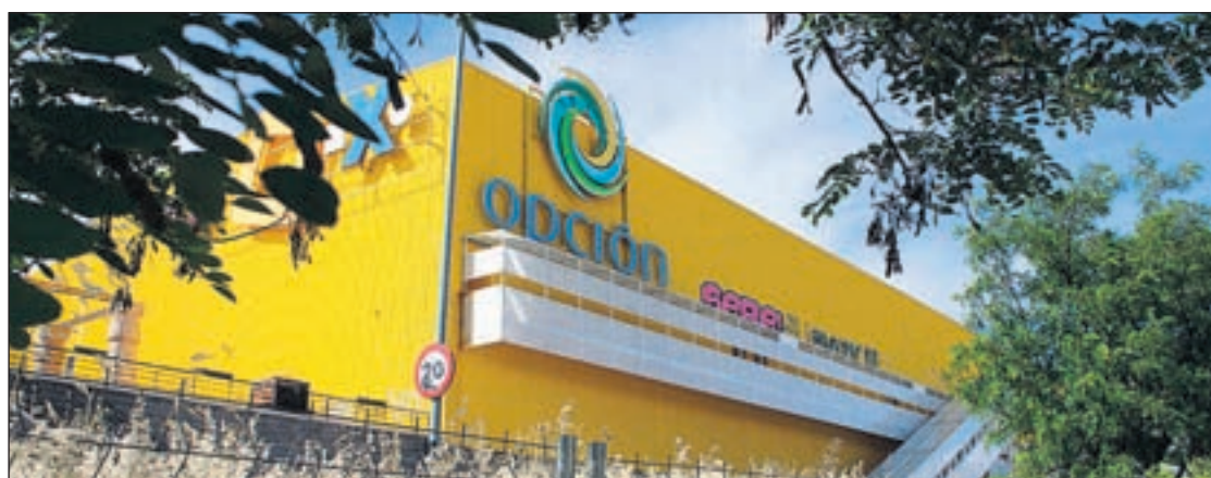
tras la reapertura, el Centro Comercial Opción contará con zonas de ocio y restauración, tiendas de todo tipo y concesionarios de vehículos y se prevé que genere cerca de 400 puestos de trabajo.
