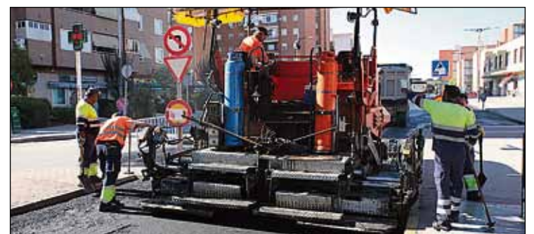
Asfaltado de una de las calles de la localidad.
