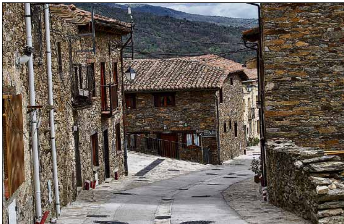
Las casas de piedra, adobe y madera de roble de la dehesa, apenas han sufrido modificaciones en su estructura desde su construcción.
