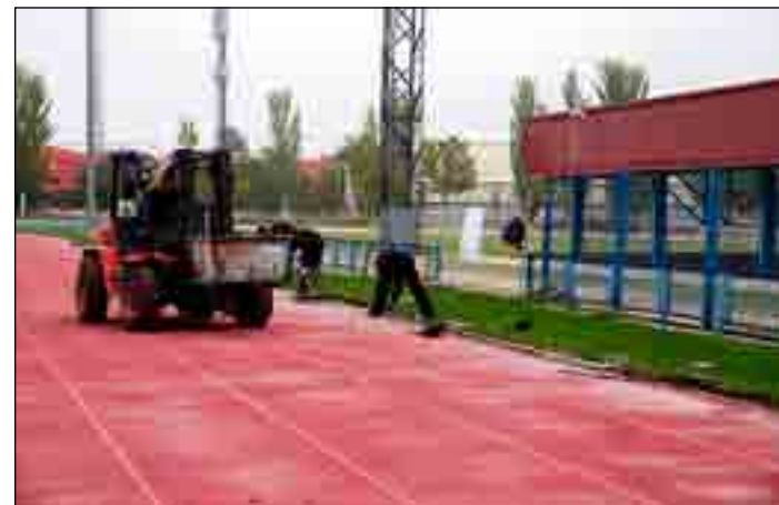
Se están construyendo y renovando diferentes instalaciones municipales.
